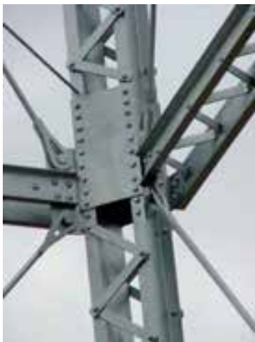
شکل ۳-۱ کاربرد پیچ اتصال
